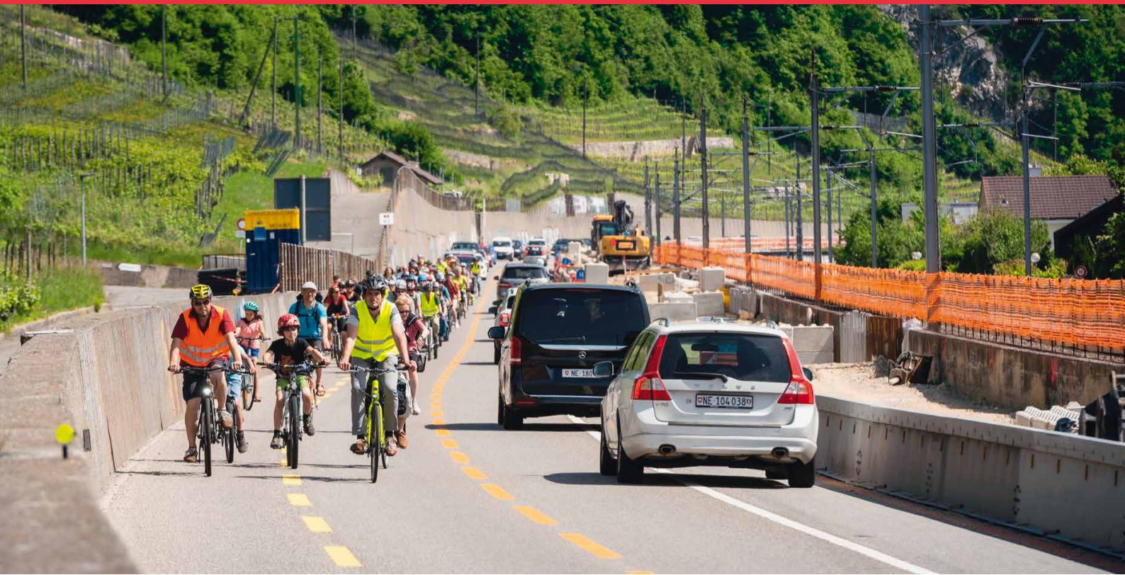
Veloausflug am 15. Mai 2022 auf der N5-Baustelle Biel - La Neuveville
